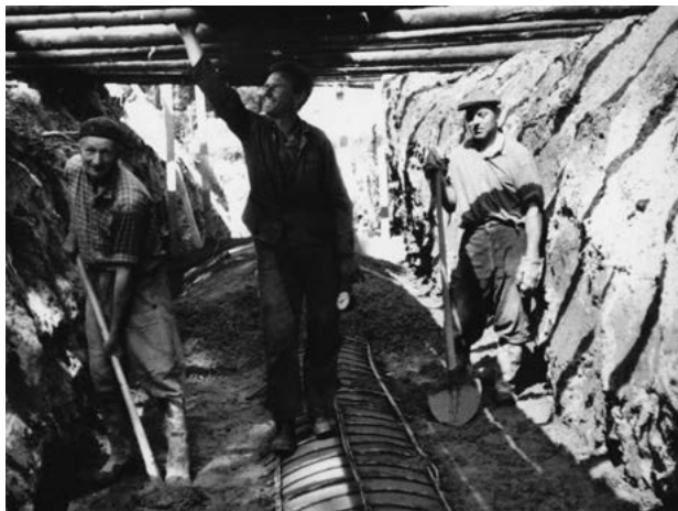
Jaroslav Šindler (vpravo) na stavbě přehrady Klíčava
